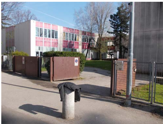
Accesso da Via De Gasperi, Dettaglio.
