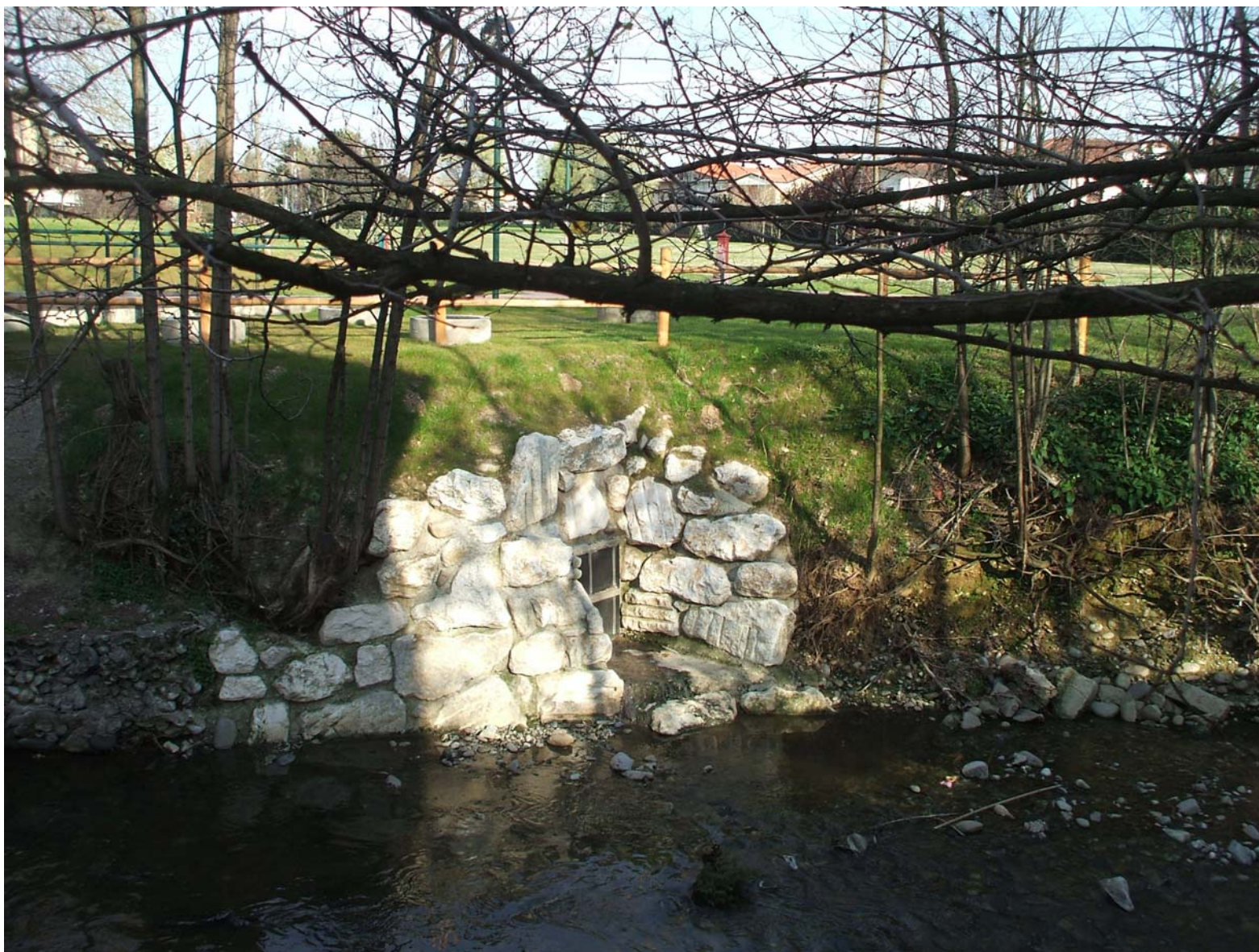
Foto n. 6: punto di sfioro in sponda sinistra del Torrente Molgora a monte dell'attraversamento pedonale che congiunge Via Alighieri al Parco Europa.
