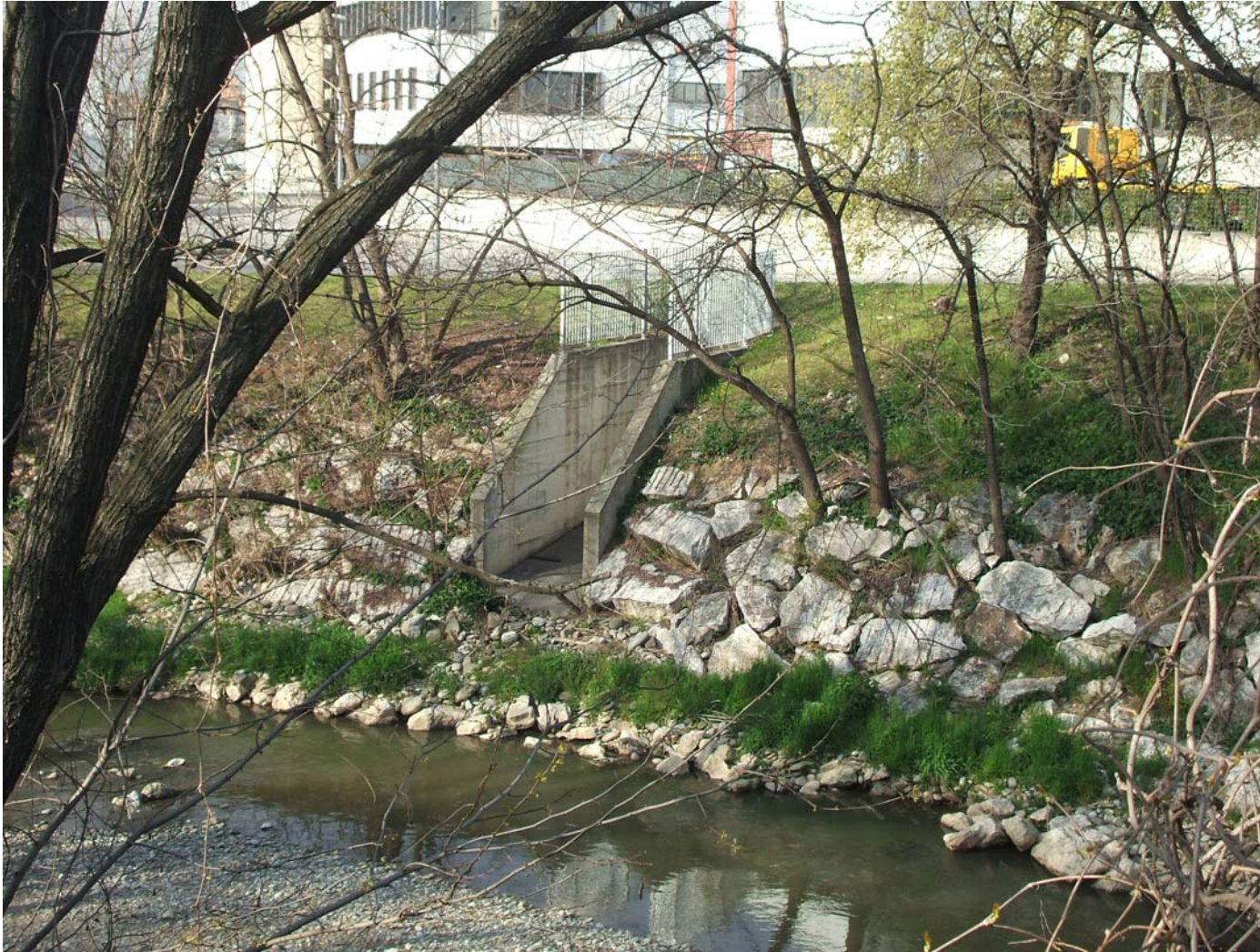
Foto n. 3 - Punto di scarico in sponda sinistra del Torrente Molgora a monte dell'attraversamento di Via Galilei
