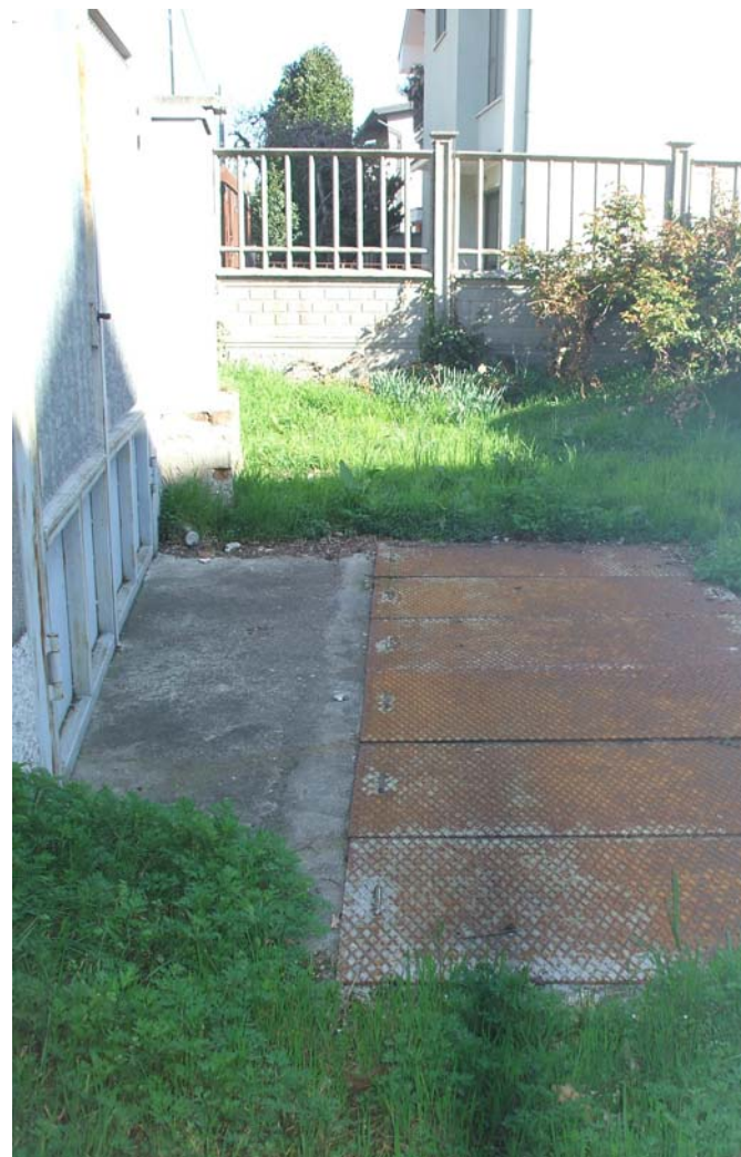
Particolare della botola di accesso alla testa pozzo
