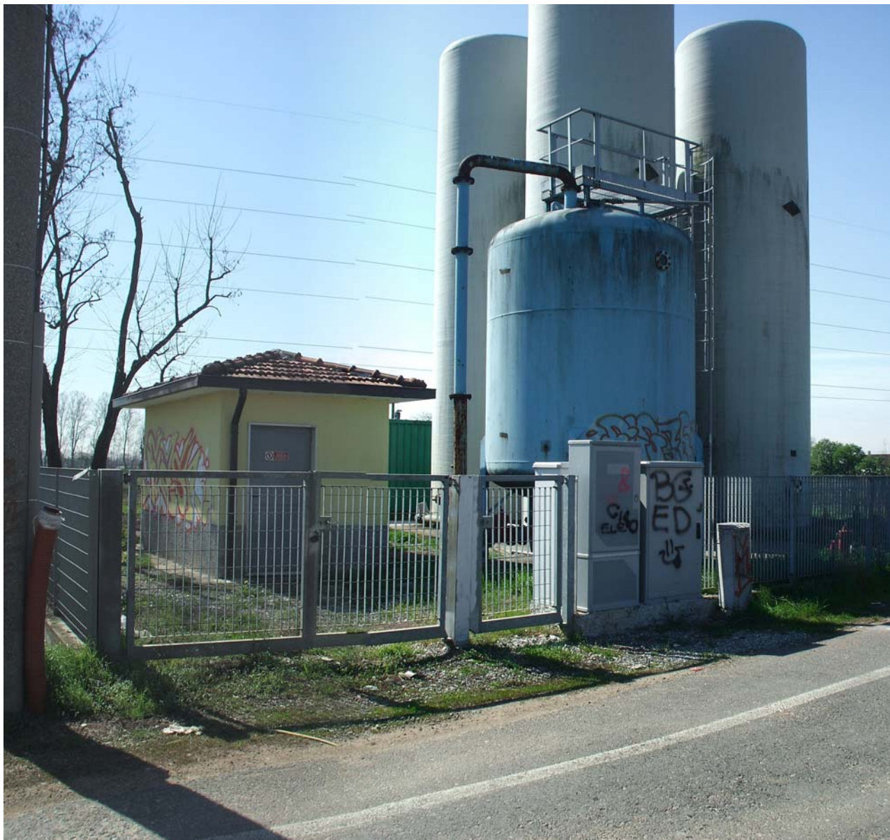
Pozzo n. 5 - CAP 015 – C.na San Francesco Cameretta ed impianto trattamento
