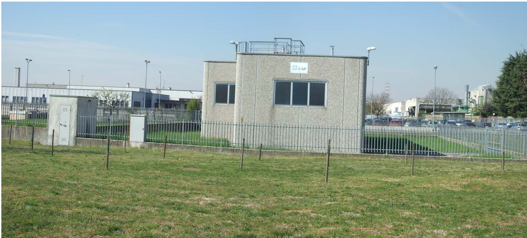
Pozzo n. 6 - Vasche di accumulo impianto Gerole (pozzo CAP 016-colonna A, CAP 018 –colonna B) Particolare della Zona di tutela assoluta
