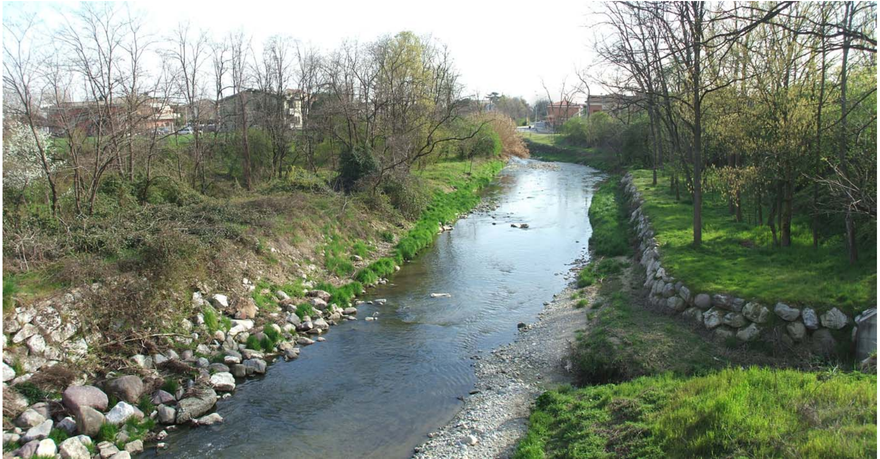
Foto n. 4: alveo del Torrente Molgora a valle dell'attraversamento di Viale dell'Industria. Visibili scogliere in massi ciclopici a protezione delle sponde e sfioratore di piena (a destra).
