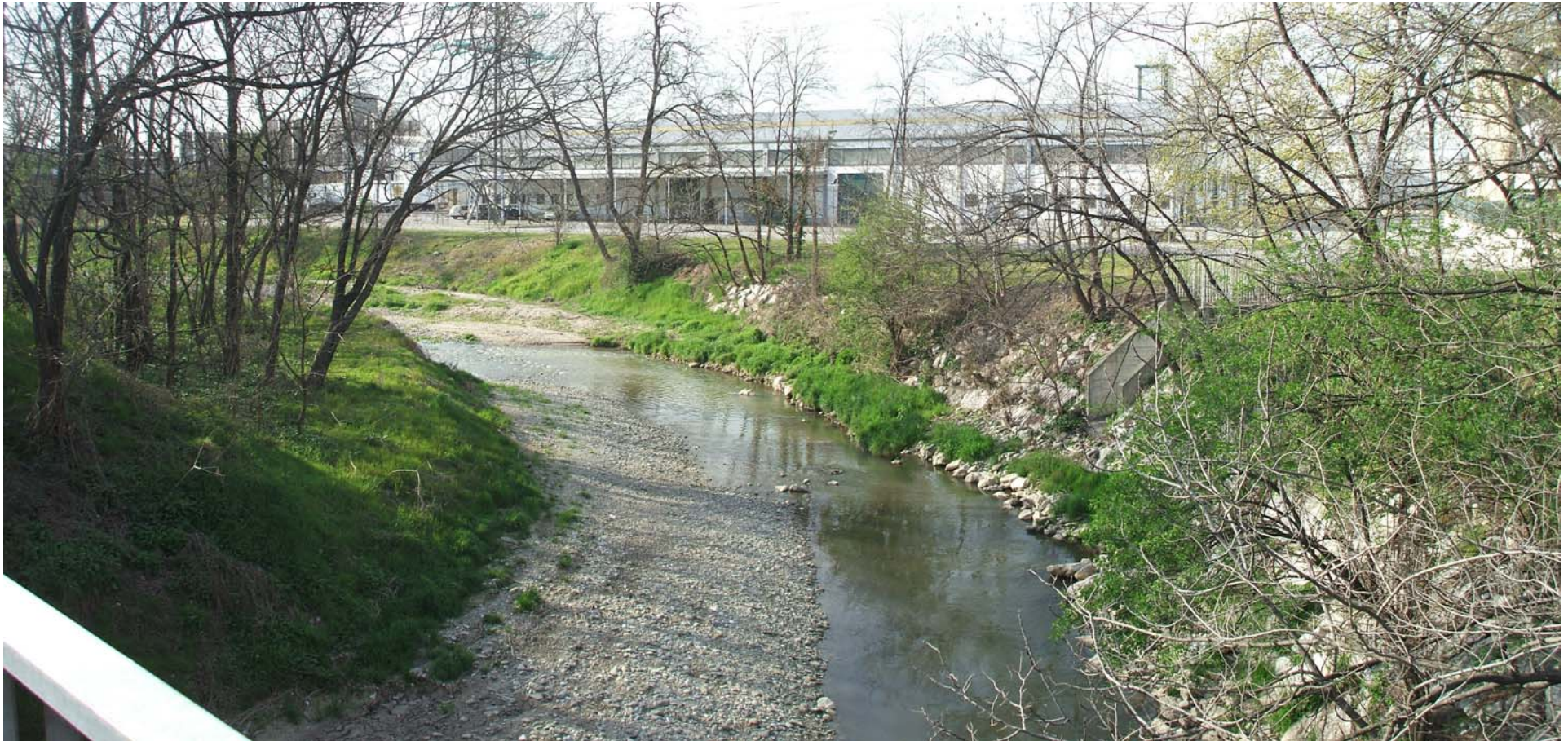
Foto n. 5: alveo del Torrente Molgora a monte dell'attraversamento di Via Galilei. Visibili scogliere a protezione delle sponde.
